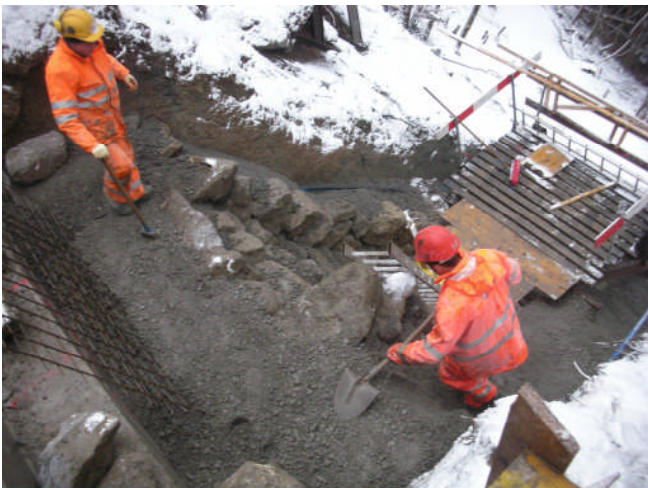
Die Ablaufrinne ist bis zu Fundament 2 erstellt
