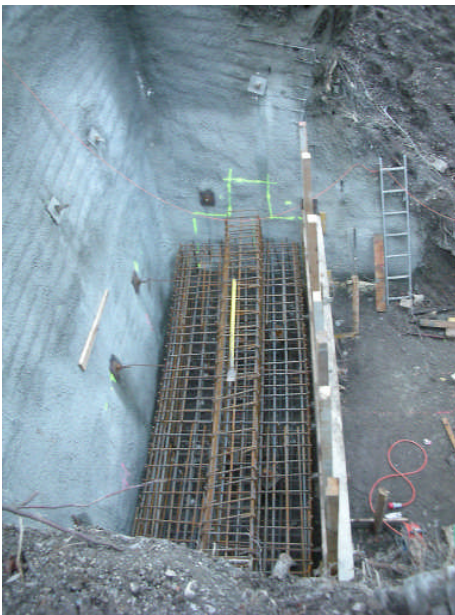
Die Ablaufrinne ist bis zu Fundament 2 erstellt
