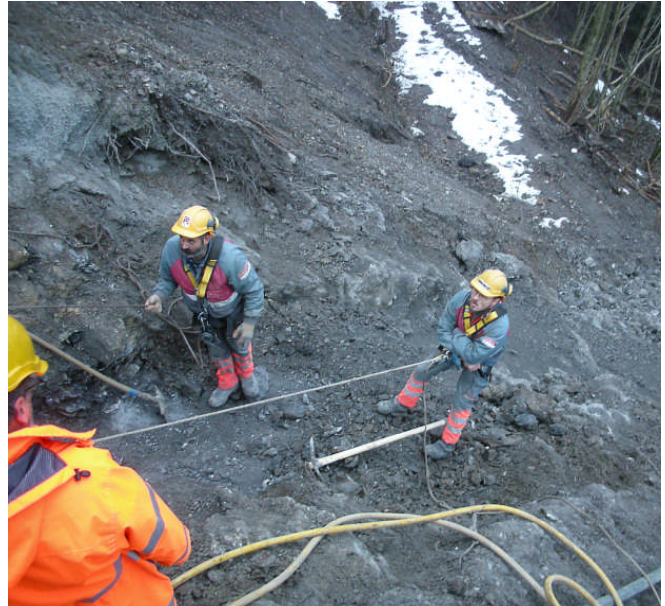
Erstellen der Rinne im Fels
