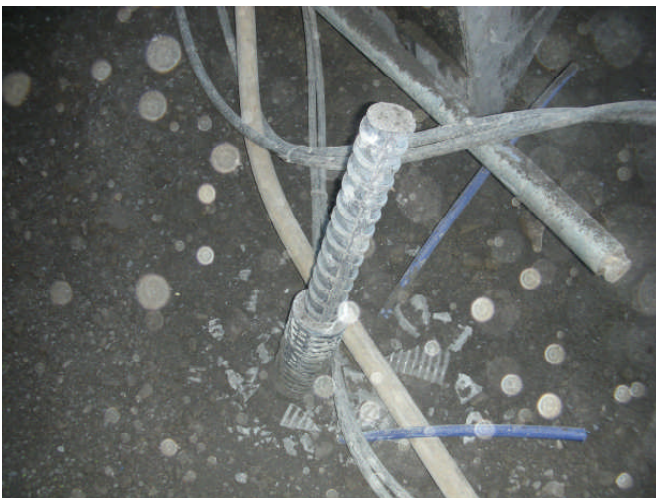
Der erste Mikropfahl ist gesetzt
