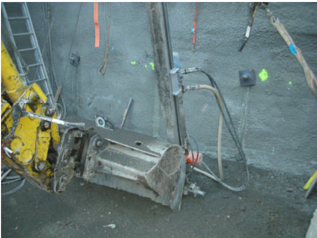
Der erste Mikropfahl ist gesetzt
