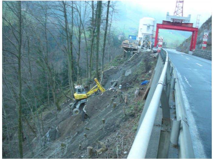
Blick in die Baugrube für Stützriegel 1
