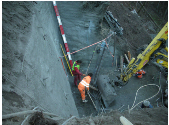
Sofortmassnahme: Vorbetonieren und verankern einer instabilen Stützmauer
