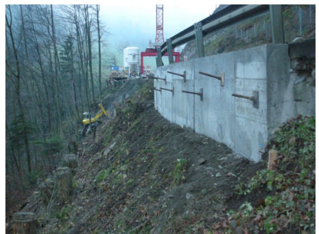
Sofortmassnahme: Vorbetonieren und verankern einer instabilen Stützmauer
