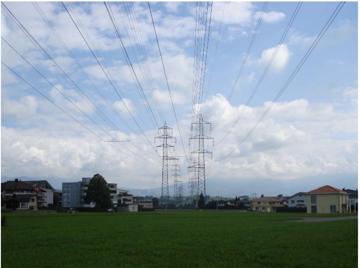
Abb. 2: Hochspannungsleitung in dicht besiedeltem Gebiet. Die Hochspannungsleitung zieht eine Schneise durch ein Dorf. Vor Inkrafttreten der NISV eingezontes Land darf auch bei Überschreitung des Anlagegrenzwertes bebaut werden.
