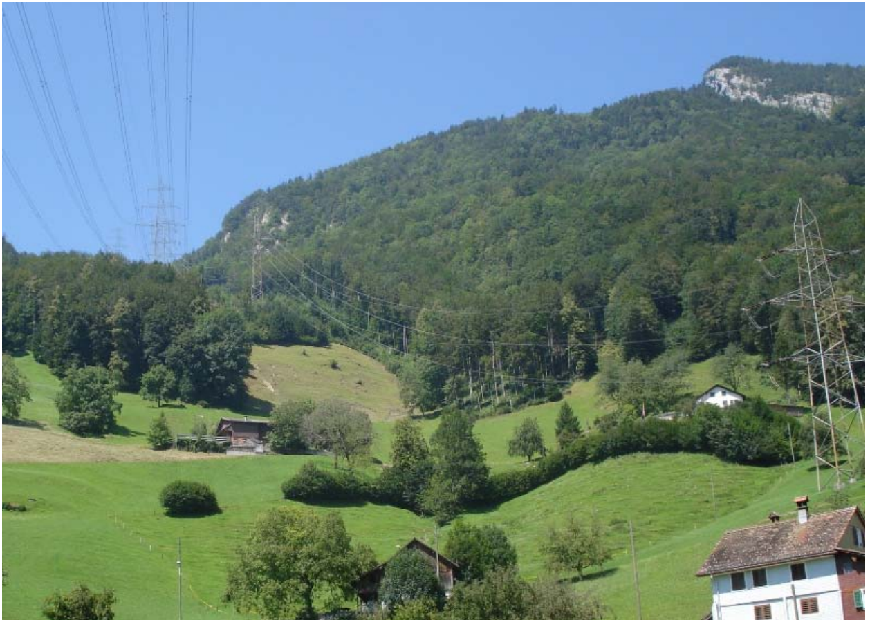
Abb. 8: Durchhängende Leiterseile. Je nach Entfernung zu den Masten ist die Distanz der Leiterseile zum Boden unterschiedlich. Ebenso kann aufgrund einer Hanglage die Distanz zu den Leiterseilen seitlich viel geringer sein als nach unten.
