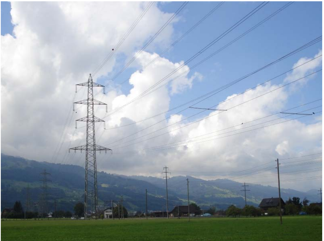
Abb. 1: Freileitungen. Das Bild zeigt unterschiedliche Typen von Freileitungen: 220kV-Leitung mit Gittermasten (links), 220 kV-Leitung mit Betonmasten (rechts) sowie dazwischen auf den kleineren Holzmasten eine 16kV-Leitung.
