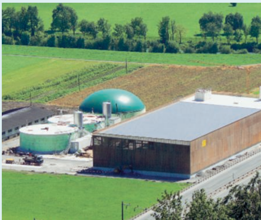
CO-Vergärungsanlage AGRO-Energie Schwyz
