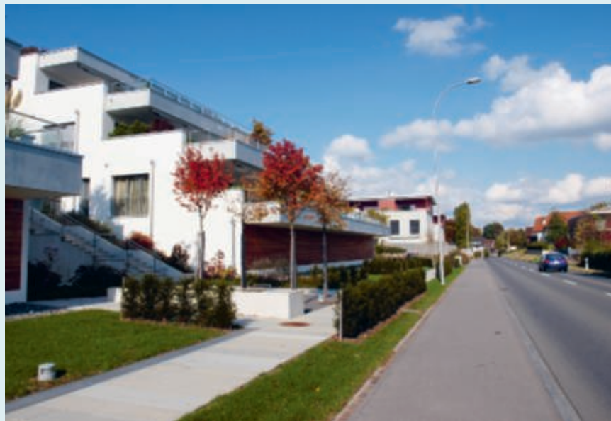
Terrassierung: Wirksame Lärmschutzmassnahme an Hanglagen
