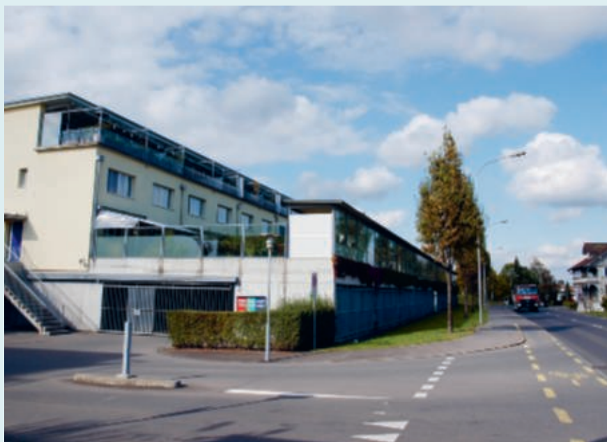
Windgeschützter Sitzplatz: Lärmschutz – funktionell ins Bauobjekt integriert
