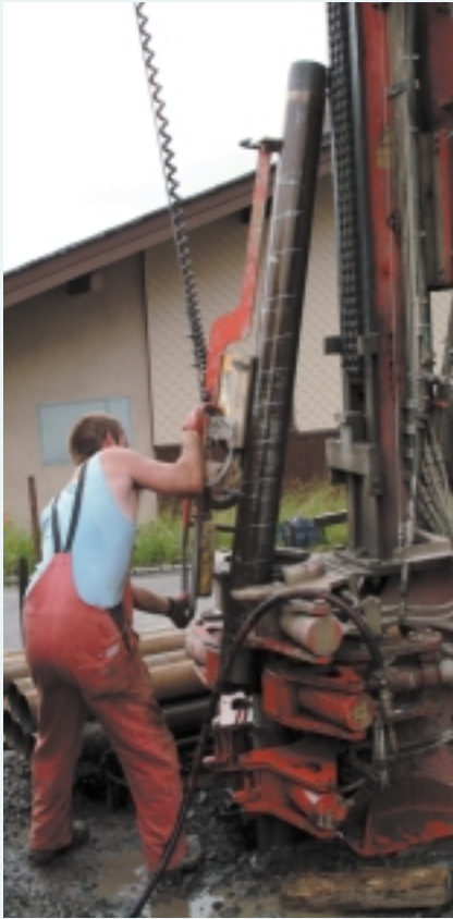
Rund 130 Meter tief ging diese Bohrung in Rickenbach. Ab 80 Meter Tiefe kämpfte sich der Bohrkopf (Foto rechts unten) durch baren Fels. Fotos: Thomas Vogel
