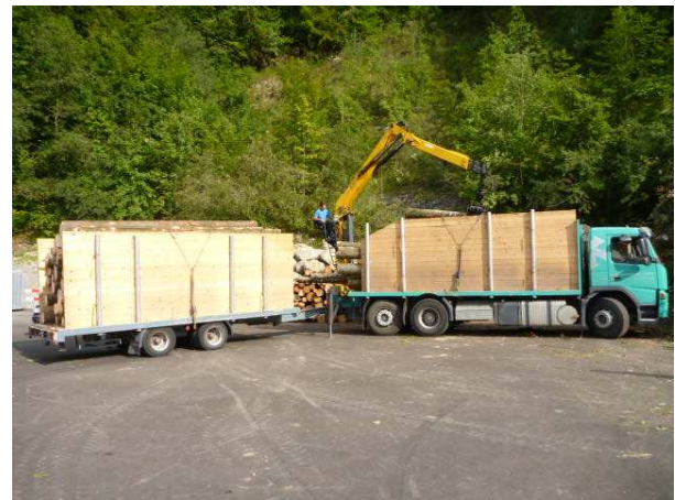
Abtransport der vorbereiteten Baumstämme zur Weiterverwendung.
