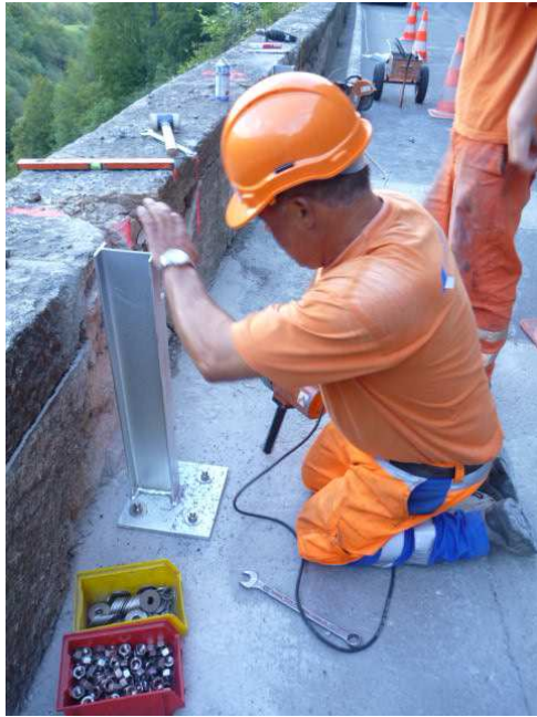
Montage der Leitschranke vor beschädigter Blocksteinmauer.
