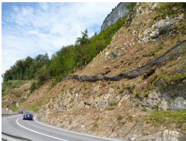
Gerodete Teilfläche beim Ausstellplatz 2, inkl. Maschendrahtnetz mit feinmaschigem Geotextil verlegt.
