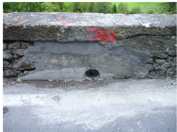
Instandgestellte Blocksteinmauer (Loch ausgefüllt mit Beton)
