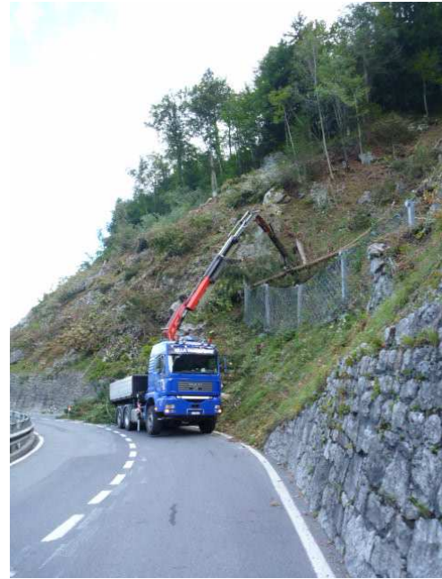
Holzereiarbeiten mit Lastwagenkran im Bereich der Runse.
