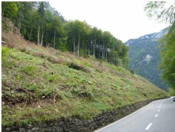
Gerodete Teilfläche zw. Bierkeller und Ausstellplatz 1.
