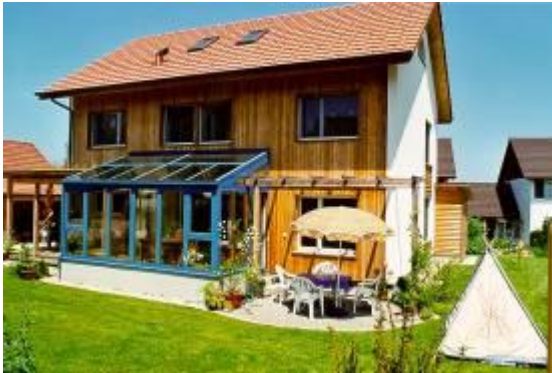
Gut: unauffällige Photovoltaikanlage auf Wintergarten
