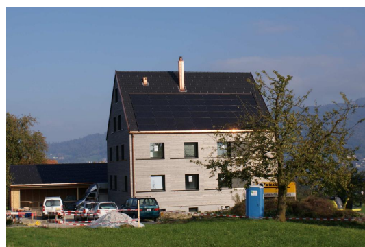
Gut: farblich gut ans Gebäude angepasste Anlage
