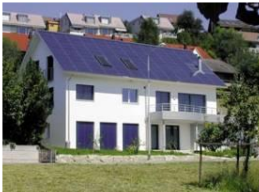
Gut: vollständige Bedeckung des Daches durch die Solaranlage
