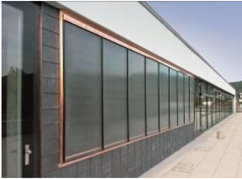
Gut: Die Solaranlagen passen ins architektonische Konzept.
