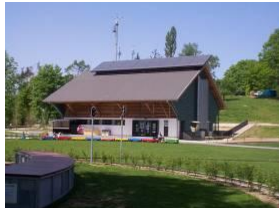
Schlecht: Die aufgesetzte Anlage wirkt wie ein Fremdkörper. Sie ist nicht integriert.
