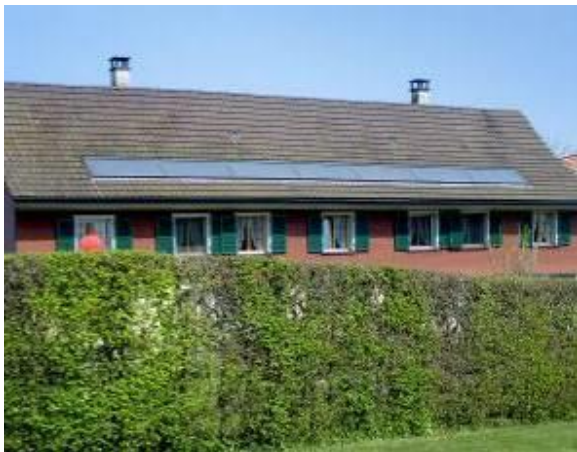
Gut: Kollektorfeld als rechteckiges Band im unteren Dachdrittel
