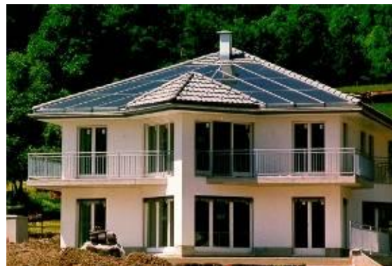
Gut: Anpassung des Kollektorfeldes an die Dachform.
