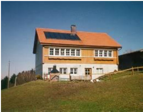
Gut: Anordnung der Kollektoren rechteckig und parallel zu den Dachkanten
