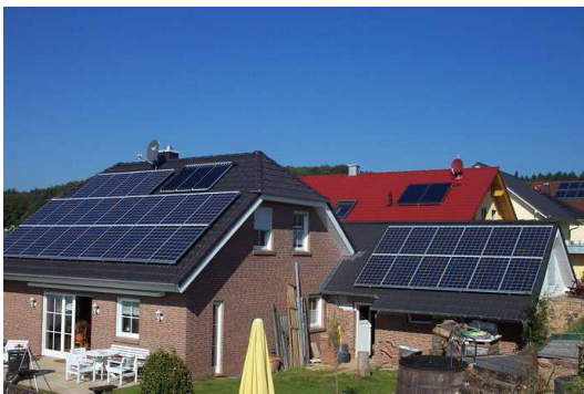
Schlecht: nicht rechteckige und auffällige aufgesetzte Anlagen
