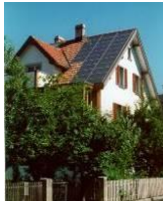
Gut: Anpassung des Kollektorfeldes an die Dachform.
