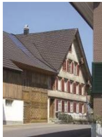
Gut: gelungene vertikale Anordnung der Kollektoren
