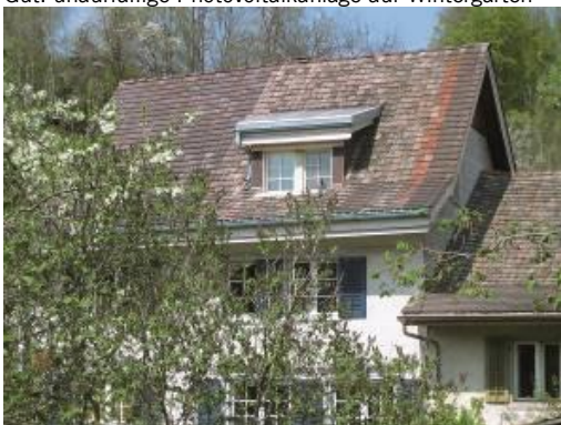
Gut: gut integrierte Anlage auf Lukarne
