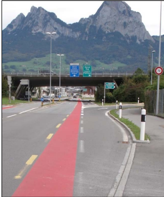
Abb. 16: Rote Markierung bei gefährlicher Querrung (TBA 2014)
