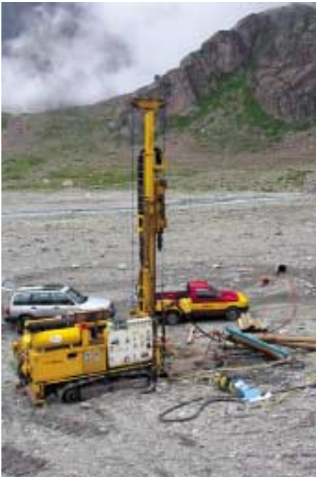
Probebohrungen zur Abklärung von Grundwasservorkommen
