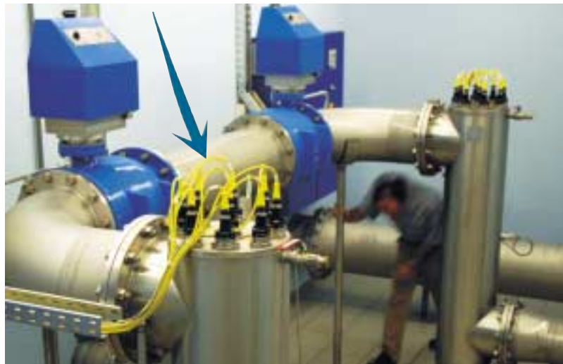
Hier wird das Wasser mit UV Licht bestrahlt
