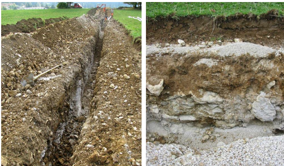
Abb. 11 > Baustelle im Berggebiet des Juras – Verlegung einer unterirdischen Stromleitung der BKW Energie AG
