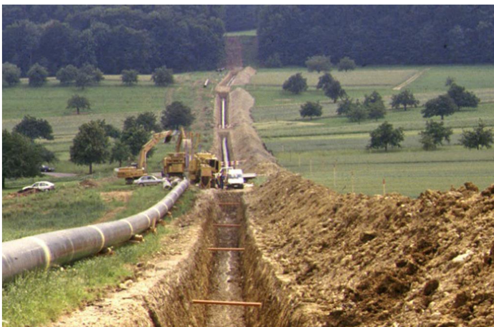
Abb. 2 > Bau der Transitgasleitung von Walbach (AG) nach Däniken (SO) im Jahr 1994
