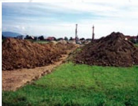
Zwischenlager von Unterboden (links) und Oberboden (rechts), unmittelbar vor der Begrünung.
