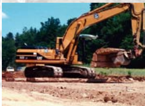
Einsatz von Baggermatratzen als lastverteilende Massnahme.
