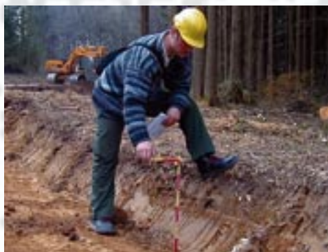
Die BBB kontrolliert die Erdarbeiten und hat auf der Baustelle Weisungsbefugnis.
