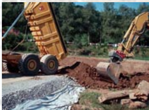
Schwere Pneufahrzeuge benötigen eine tragfähige Transportpiste.
