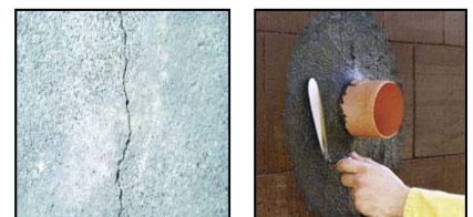
Abdichtung von Rissen und Leitungsdurchführungen
