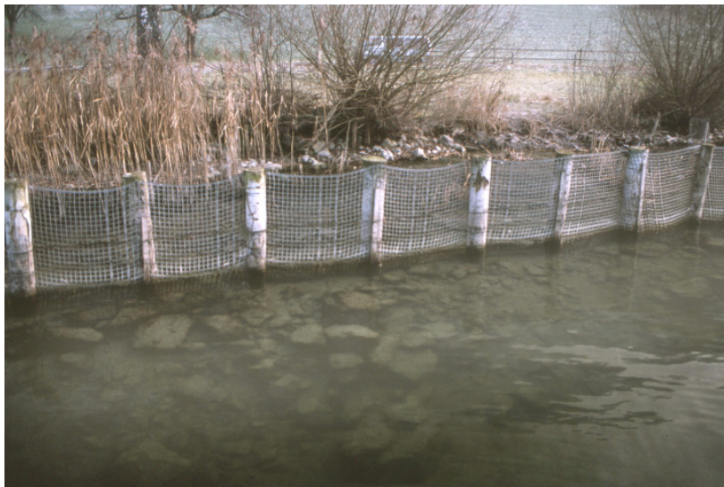
Böschungsfussicherung aus Steinen und Schutzzaun (Eiola, Uferabschnitt 15)
