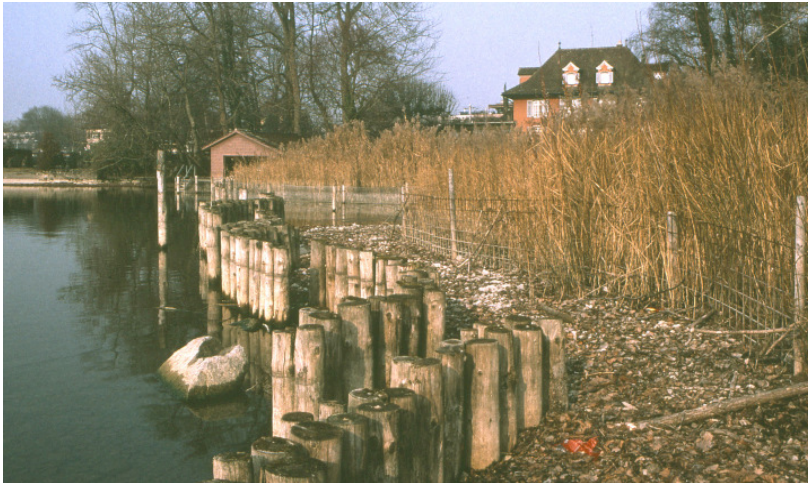
Palisadenreihe und Zaun zum Schutz der Kiesschüttung und der Schilfpflanzung vor der Lorzemündung (Uferabschnitt 2, 2006)
