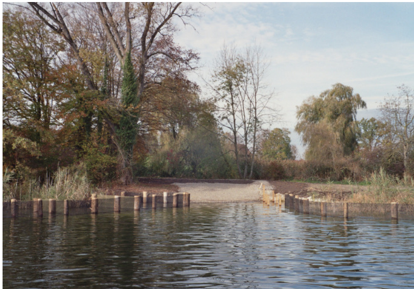
Uferrenaturierung in Zwijeren: Entfernung der Ufermauer, Abflachung des Ufers, Schutzbauten für Schilf, Gehölzpflege und landseitige Aufwertung
