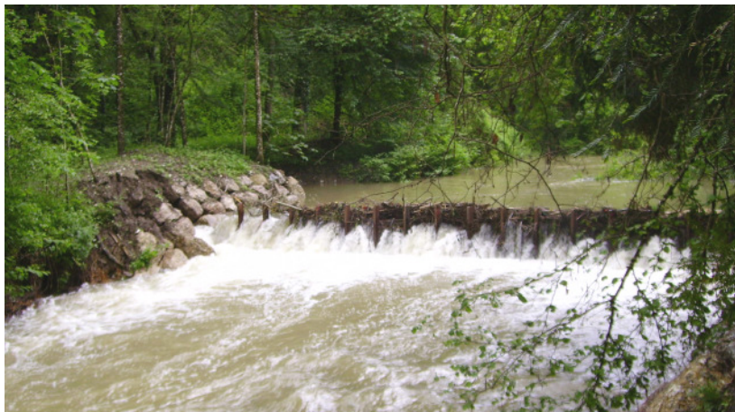
Rechen zum Rückhalt von Schwemmholz im Lorzetobel
