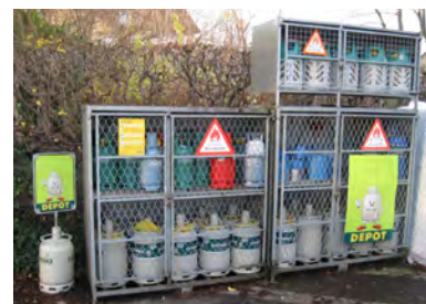
Flüssiggasflaschen wie Propan und Butan sind in einem Gitterschrank im Freien zu lagern.
