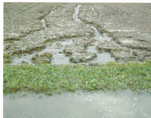
Erosionsrinnen durch Wasserzufluss von einer Strasse.
