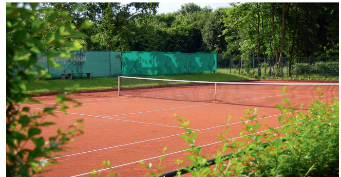
Unabdingbare fachgerechte Entsorgung bei der Sanierung von Sportplätzen Bild: pixabay.com
