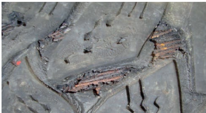
Stahlgürtel und Abdecklage sichtbar.
