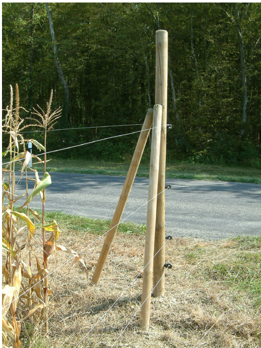
Die Isolatoren sollten aussen angebracht sein. Eckpfähle können zusätzlich mit zwei Schrägpfähle dauerhaft verstärkt werden.
