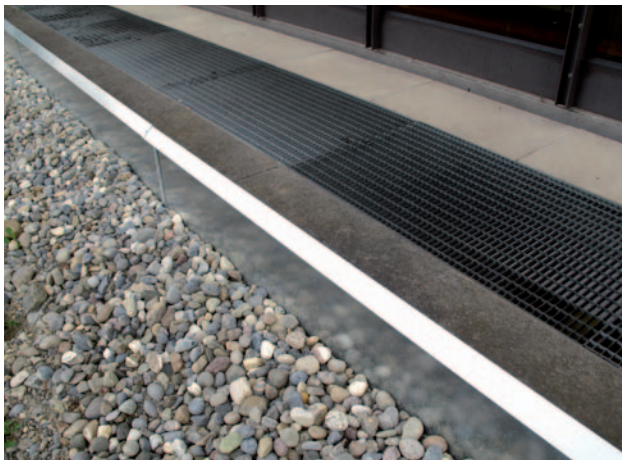
Abb. 9 Überhöhter Rand um Treppenabgang
