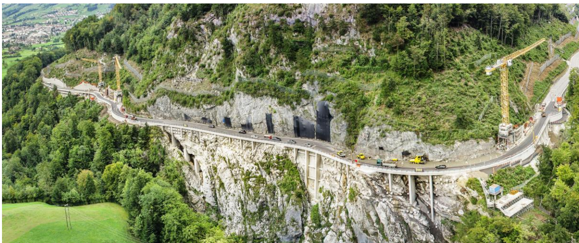
Abbildung 9: Strassenbau beim Gibelhorn, Muotathalerstrasse
