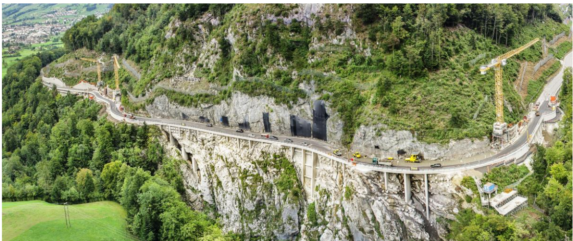
Abbildung 9: Strassenbau beim Gibelhorn, Muotathalerstrasse
