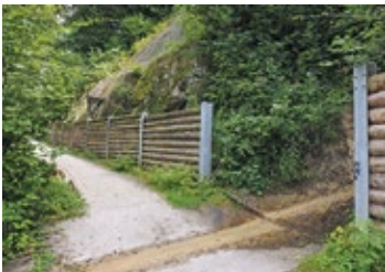
Über Furten wird das Material von Murgängen in die Aare geleitet.
