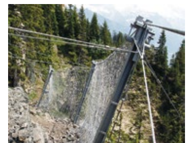
Steinschlagnetze oberhalb Bergwanderweg Schynige Platte–Breitlauenen.
