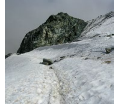
Brüchige Felspartie oberhalb des Alpinwanderweges zur Britanniahütte.
