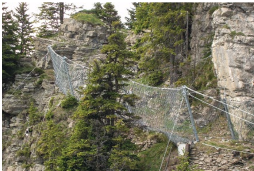
Steinschlagnetze oberhalb Bergwanderweg Schynige Platte–Breitlauenen.
