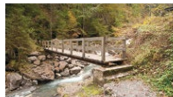
Über reissenden Fliessgewässern wird auf Wanderwegen ein beidseitiges Geländer empfohlen.
