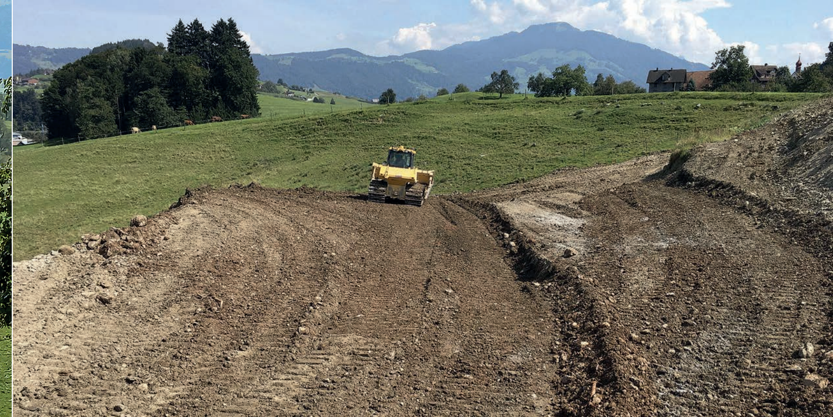
Foto 8: Raupenfahrzeug verteilt und verdichtet abgelagertes Aushubmaterial.
