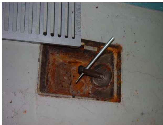
Putzdeckel für Reinigung des Syphons
