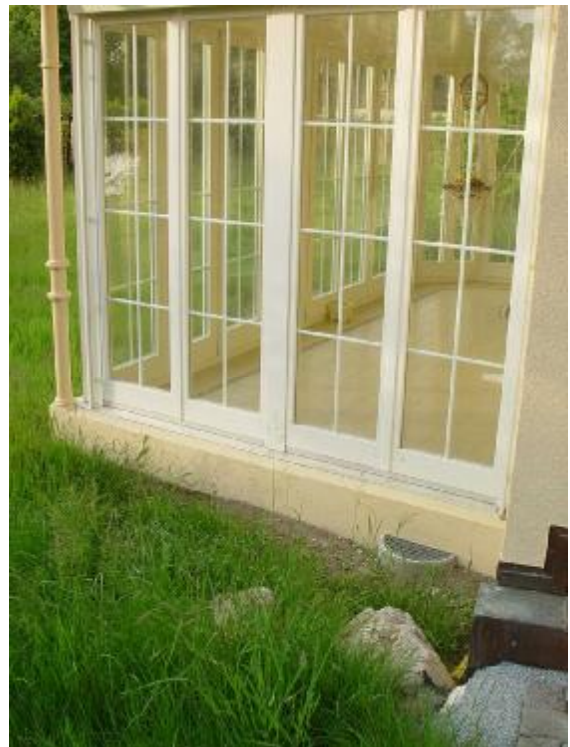
Separate Luftfassung mit aussen liegendem Schacht (m. Gitterrostabdeckung) Unterhalt muss gewährleistet sein!
