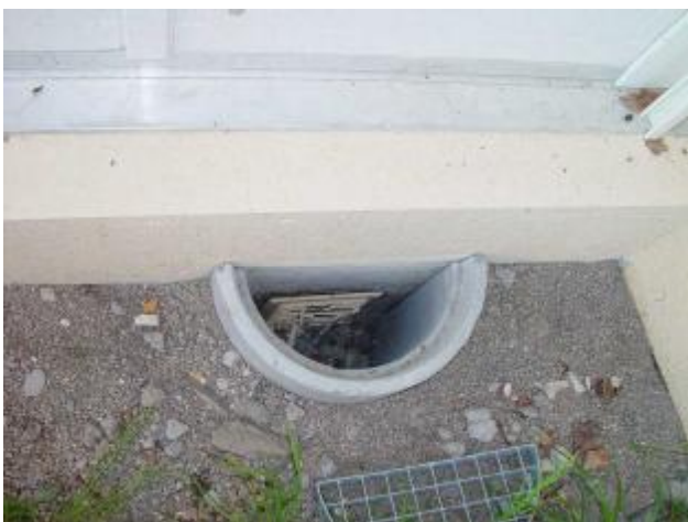
Separate Luftfassung mit aussen liegendem Schacht (m. Gitterrostabdeckung) Unterhalt muss gewährleistet sein!
