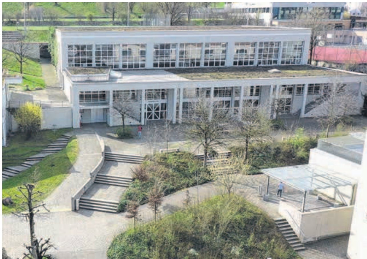
Die Dreifachturnhalle der Kantonsschule Ausserschwyz und des Bildungszentrums Pfäffikon wird umfassend saniert.
