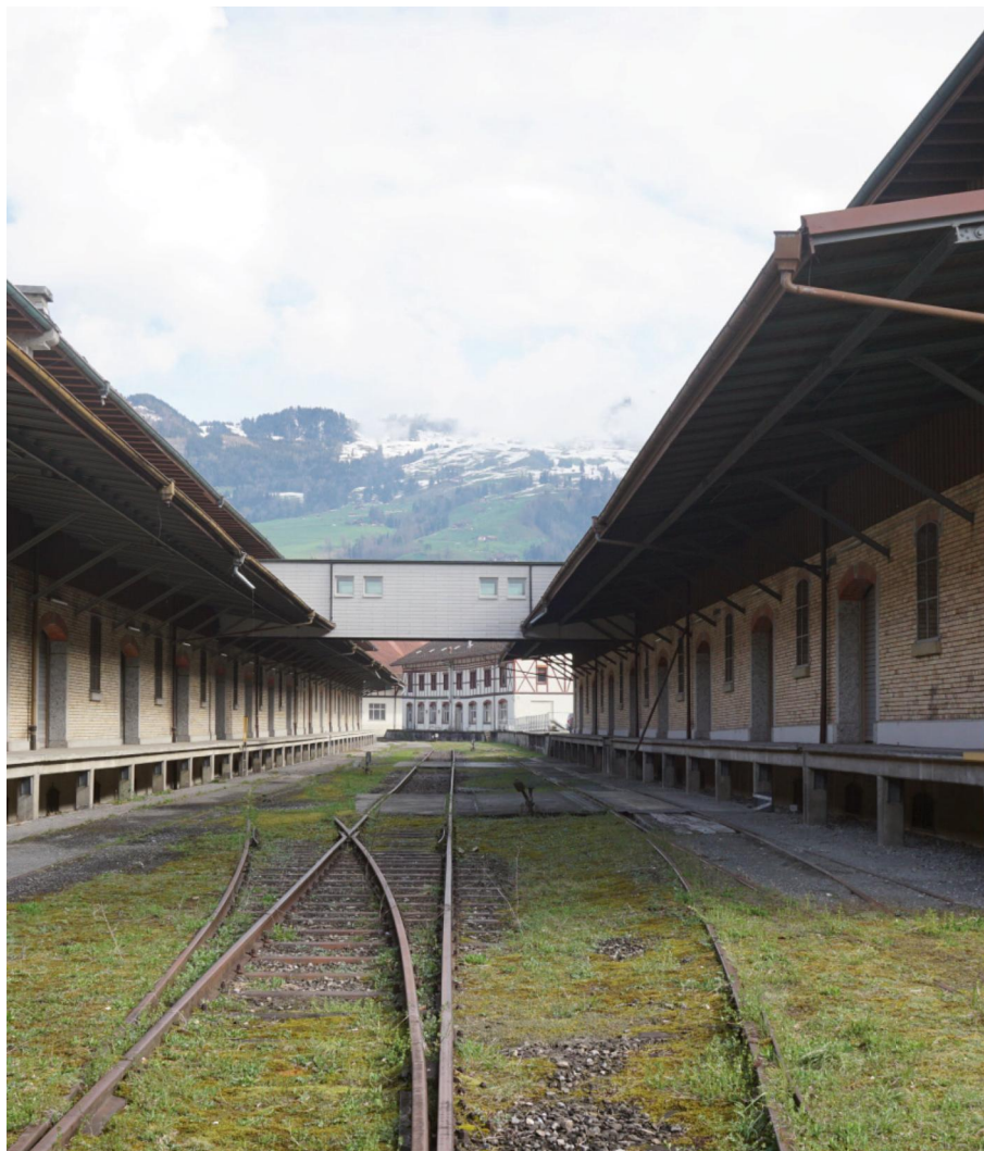
Abb. 10: Versorgungsgebäude 31-34 mit Gleisraum Bauhistorisches Gutachten, Mai 2019
