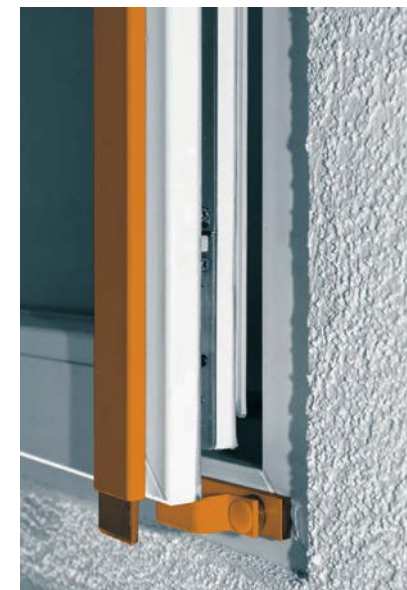
Abbildung 12: Fensterstangenschluss mit Verriegelungspunkt unten
