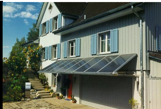
Schlecht: auffällige Solaranlage auf unnötig wirkendem Vordach.
