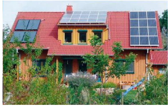
Schlecht: mehrere zufällig angeordnete Kollektorfelder
