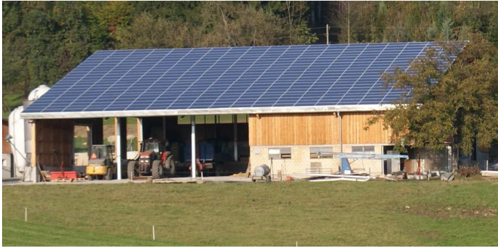
Schlecht: auffällige Farbe von Kollektoren und Kollektorrahmen
