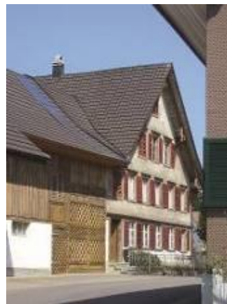
Gut: gelungene vertikale Anordnung der Kollektoren
