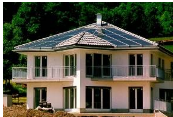
Gut: Anpassung des Kollektorfeldes an die Dachform.
