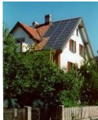
Gut: Anpassung des Kollektorfeldes an die Dachform.
