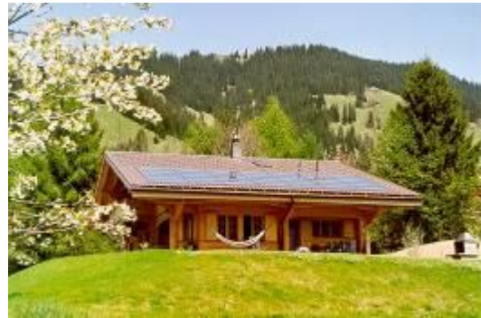
Gut: Anordnung der Kollektoren in der unteren Dachhälfte
