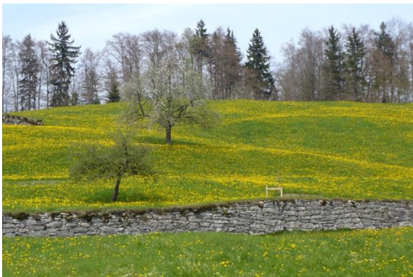
Bruchsteinmauer auf dem Mueterschwanderberg
