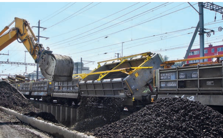
Abb. 19: Schotterentsorgung Gleisbau, Foto © AfU
