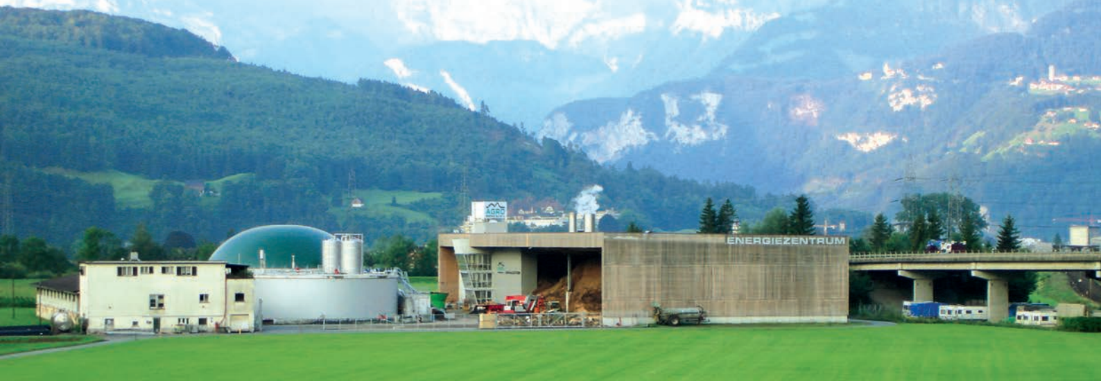
Abb. 28: Agro Energie, Altholzverbrennung für Strom- und Fernwärmeversorgung, Foto © AfU
