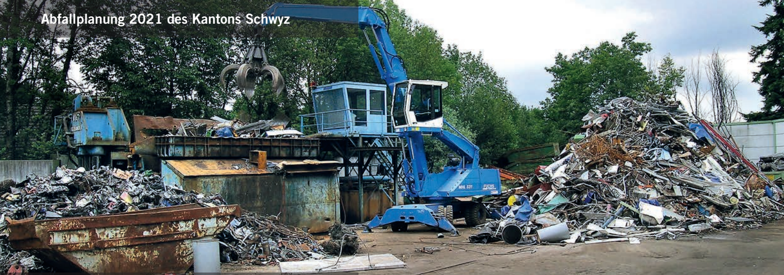
Abb. 4: Altmittelrecyclinganlage, Foto © AfU
