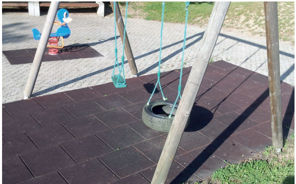
Fallschutzplatten aus Reifengranulat
