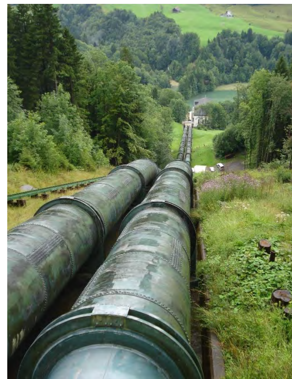
Druckleitung KW Wägital
