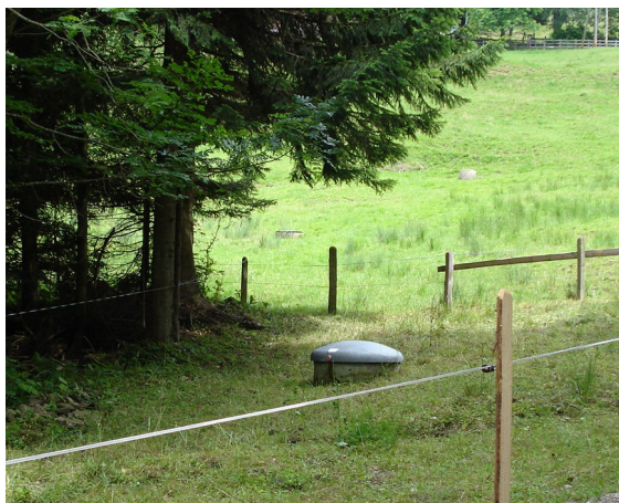
Schutzzonen bei Grund- und Quelfassungen sollen das Trinkwasser schützen, wie hier in Küsnacht. Bild: AfU
