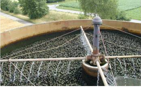
Abbildung 28: Tropfkörperverfahren (links) und Scheibentauchtropfkörper (rechts)
