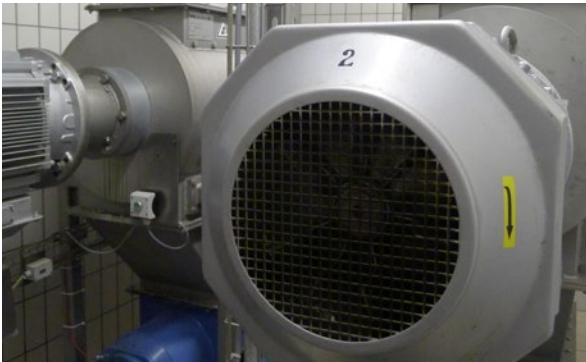
Abbildung 43: Über die Hammermühle werden Festabfälle zu flüssigem Abfall zerkleinert.
