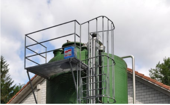
Abbildung 25: Wirbelbettreaktor (links) gefüllt mit kleinen Aufwuchskörpern (rechts)
