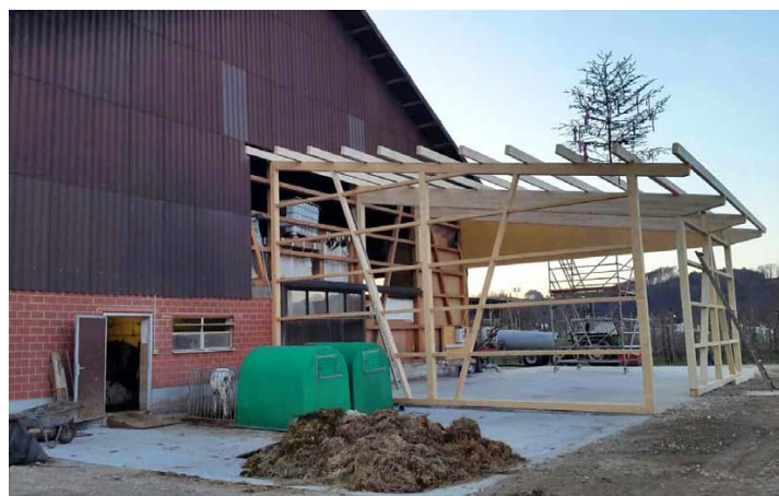
Bau einer Remise
