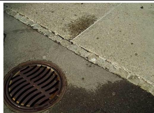
undichte Fuge Übergang Beton-Asphalt
