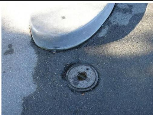
undichter Bereich um Schacht
