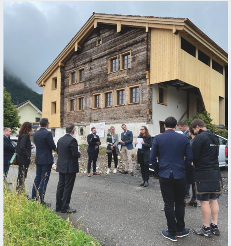
Hauptansicht des Blockbaus nach der Restaurierung.
