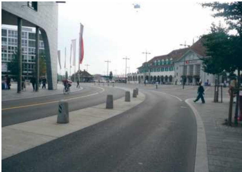
Eine flächige Querung ist möglich dank des Mehrzweckstreifens in der Fahrbahnmittle.
