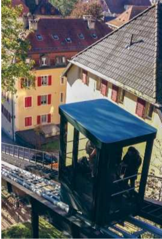
Der Fussgänger-Schräglift verbindet das Ortszentrum mit dem höher gelegenen Bahnhof auf elegante Weise.
