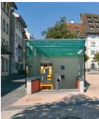
Attraktiver und sicherer Zugang zu einem Parkhaus.
