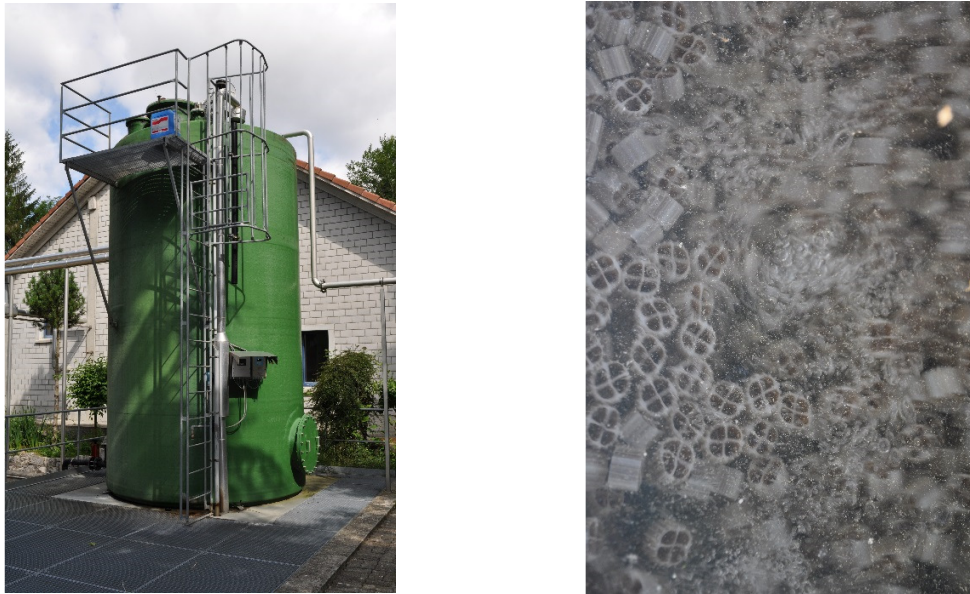
Abbildung 25 Wirbelbettreaktor (links) gefüllt mit kleinen Aufwuchskörpern (rechts).
