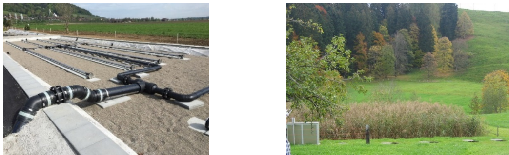
Abbildung 29 Bepflanzte Bodenfilter. Links: Im Bau, rechts: Bewachsen.
