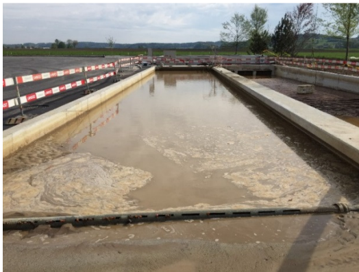
Abbildung 18 Mit Tonmineralien durchsetztes Abwasser aus Karotten-Rüstanlagen, dessen Schmutzstoffe sich kaum absetzen lassen.
