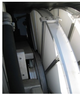
Abbildung 36 Tuchfilter (links) und Polstofffilter (rechts) (Photo: Mecana AG).
