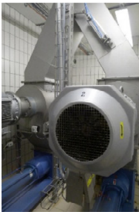
Abbildung 43 Zu flüssigem Abfall zerkleinerte Festabfälle über die Hammermühle.
