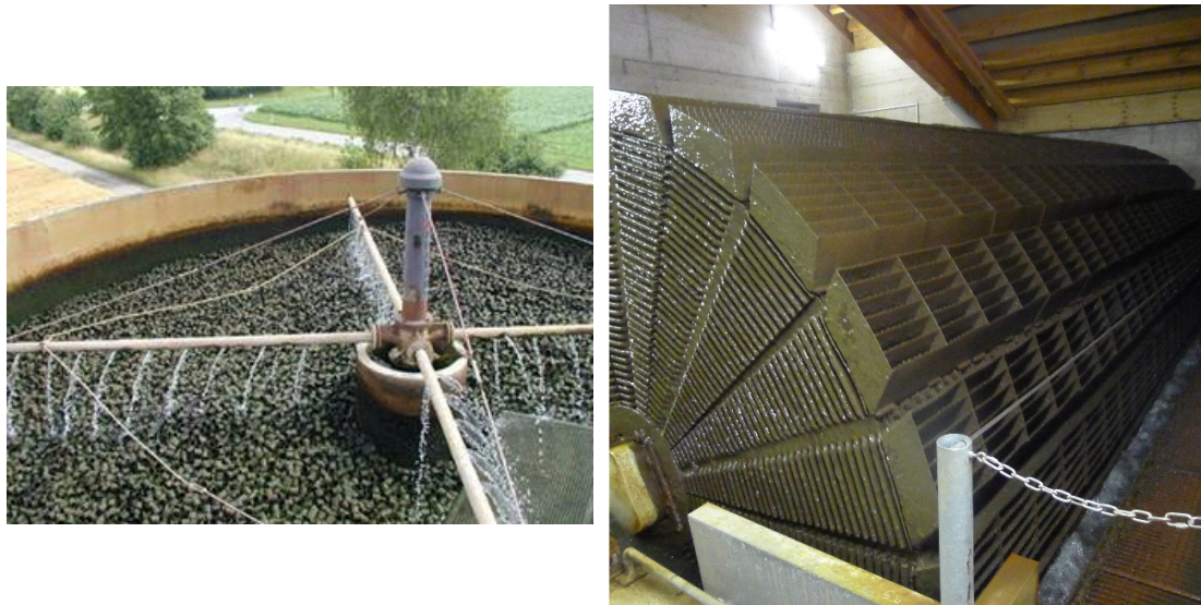
Abbildung 28 Tropfkörperverfahren (links) und Scheibentauchtropfkörper (rechts).
