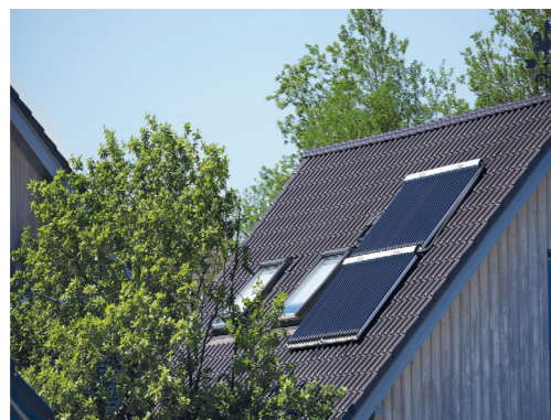
Foto mit freundlicher Genehmigung der Vaillant GmbH. www.vaillant.ch
