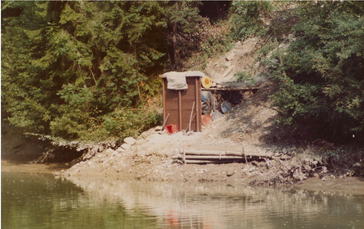
Die erste Schanze bestand aus einbetonierten Pfosten, Brettern und einer Hinterfüllung mit alten Fässern und Erdmaterial. Auf dem Schanzentisch lag eine dünne Betonschicht.
