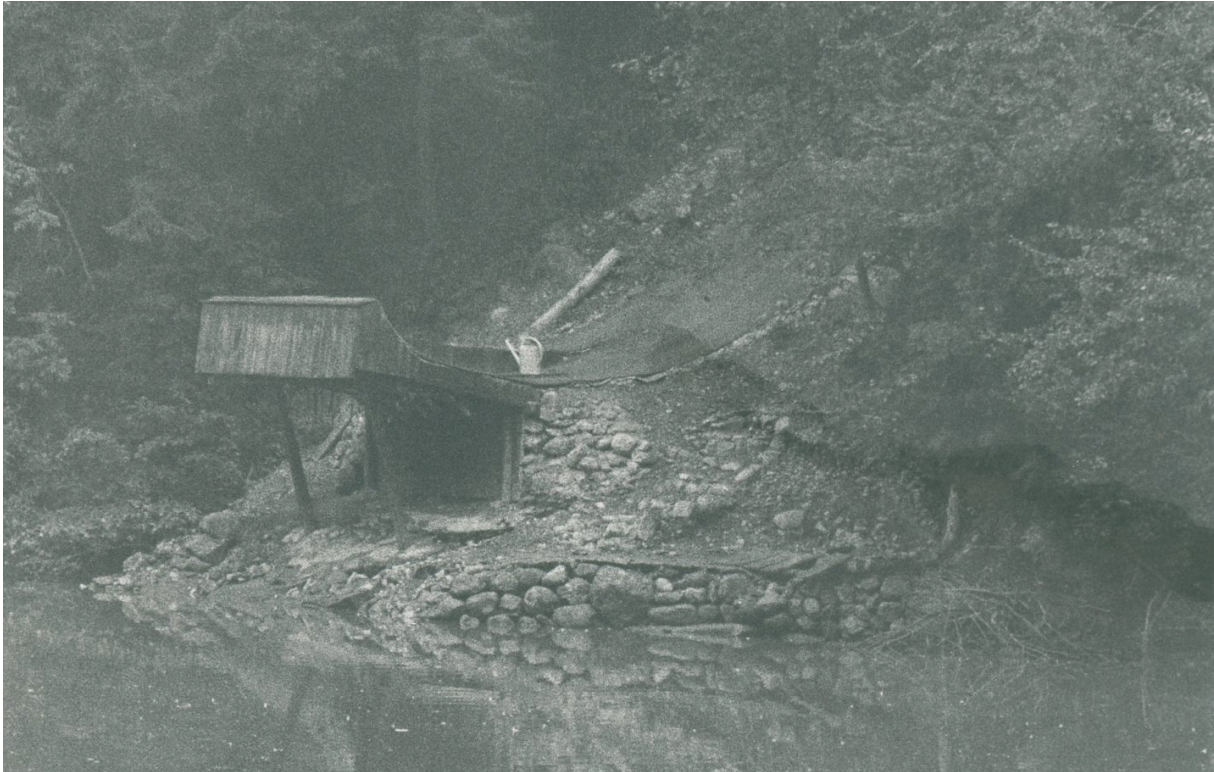
Zu einem unbekanntem Zeitpunkt wurde der Schanzentisch mit einer Betonkonstruktion verlängert.
