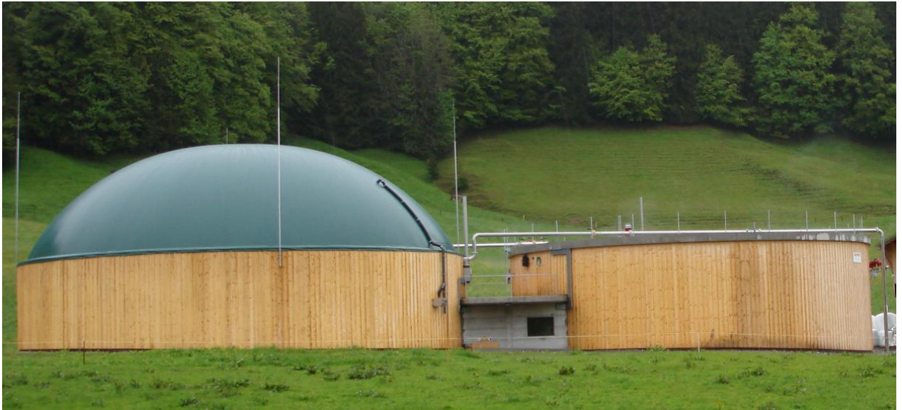
Abbildung 5: Biogasanlage in Einsiedeln
