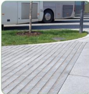
EHL AG Ökopflaster; FQP 2021: Betonsteine mit aufgeweiteter Sickerfuge und Splitt Füllung
