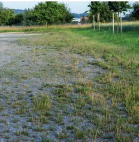
EHL AG Ökopflaster; FQP 2021: Betonsteine mit aufgeweiteter Sickerfuge und Splitt Füllung
