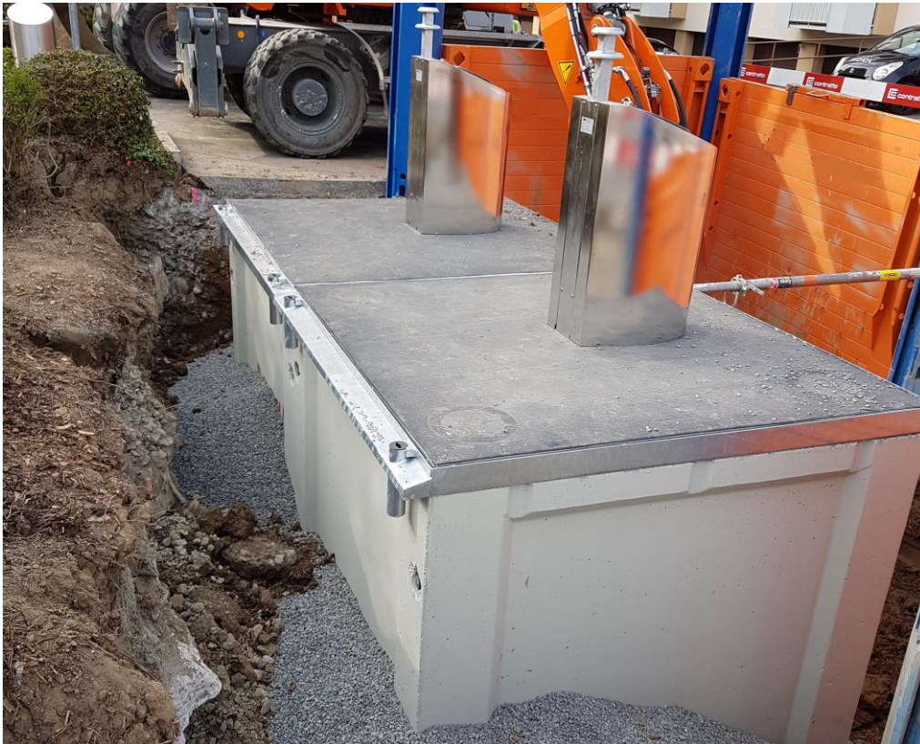
Abbildung 1: Einbau Unterflurcontainer für Siedlungsabfälle
