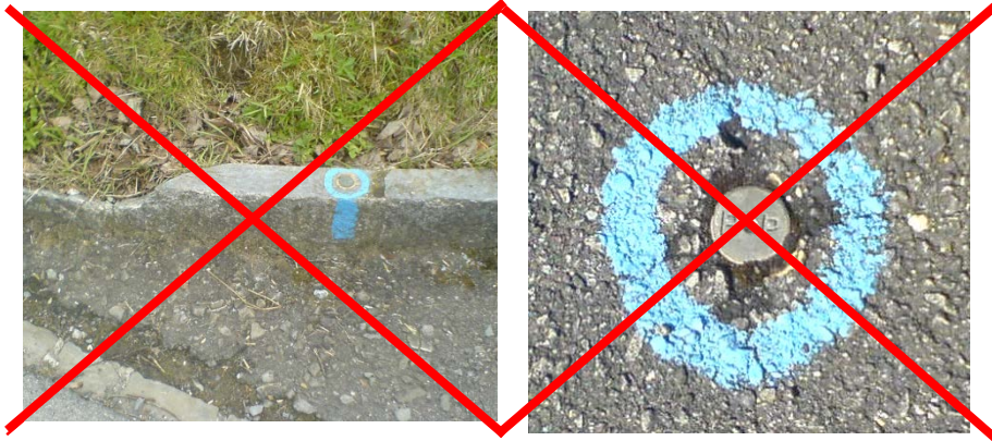
Abb. 7: unzulässiger Bolzen in Randstein
