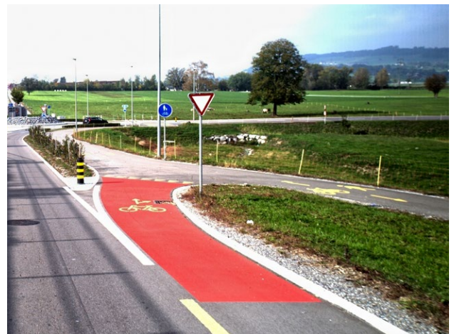
Abbildung 12: Der Kanton ist zuständig für Rad-/Gehwege entlang von Kantonsstrassen; daran anschliessende Velowege obliegen dem jeweiligen Strassenträger (Kantons-/Sulzstrasse, Reichenburg)
