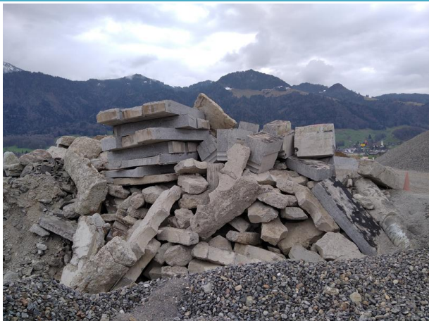
Abbildung 6: Aufbereitungsplatz für Mineralische Bauabfälle
