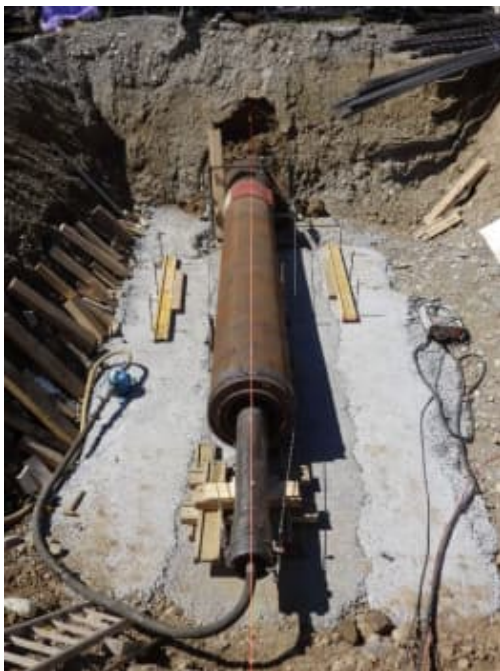
Abbildung 23: Schlagvortrieb beim Bau und mit eingezogenen Rohren
